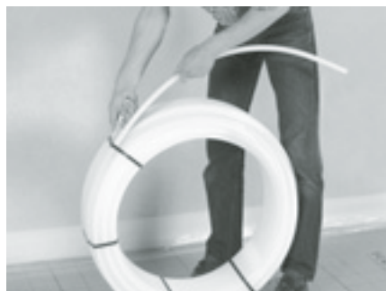
Tackersystem-Heizrohr mit Hilfe des ...
