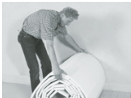
Tackersystemelemente auslegen und ausrollen.
