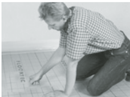
Dämmrollen sind mit einem 3 cm Selbstklebestreifen versehen und überlappen am Stoß.
