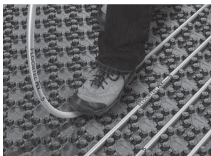
Das flexible und leicht zu verlegende Pe-Xcellent 5 Fußbodenheizungsrohr (14 x 2 mm, 17 x 2 mm) oder Aluverbundrohr (16 x 2) einfach mit dem Fuß in die trittfest ausgeschäumten Rohrhaltenoppen eindrücken.
