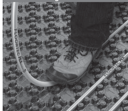
Abb. 1: Pe-Xcellent 5 Fußbodenheizungsrohr Verlegung
