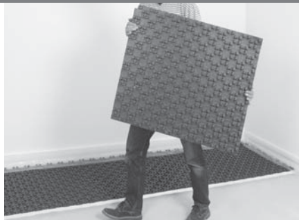
Verlegung von links nach rechts.
