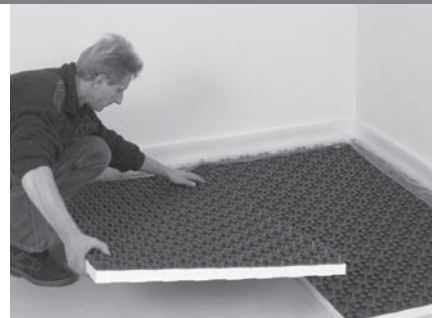
FLOORTEC System-Noppenplatten auslegen.
