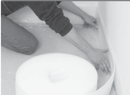
Randdämmstreifen mit seitlicher Folienschürze auslegen.
