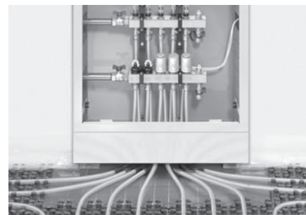
Abb. 4: Heizrohr am Verteiler anbringen, fertig!
