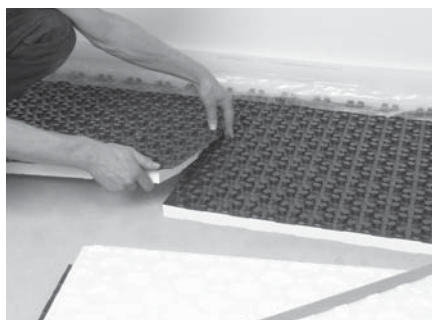
Schnelle und saubere Verlegung durch Überlappungstechnik.
