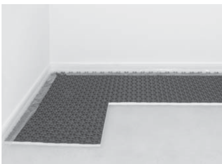
Mit dem abgeschnittenen Elementteil nächste Verlegereihe beginnen.
