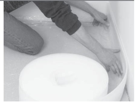
Abb. 1: Randdämmstreifen mit Foliestreifen
