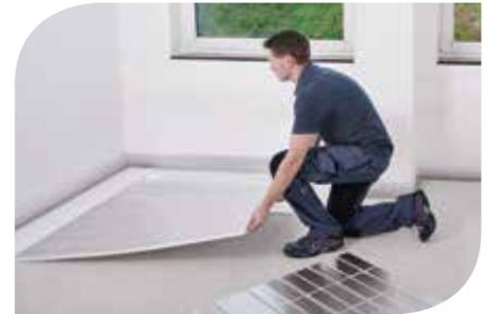
Beim TOP15 System müssen die Kopfelemente und die Heizelemente vollflächig auf dem Untergrund verklebt werden. Ecofix Kleber von COSMO.
