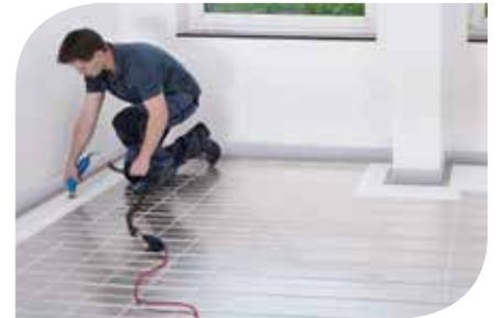
Mit dem Heißschneider individuelle Rohrführungen ausschneiden. Lange Rohrführungen in Wellenlinien ausschneiden.
