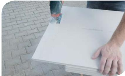
Letztes Element einer Reihe auf Länge kürzen (z.B. mit Kreissägeblatt Diamaster oder Stichsägeblatt T141 HM, Bosch).
