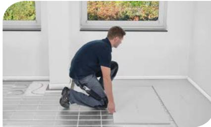
Das Element in der Nut-Feder-Verbindung zusammenschieben.
