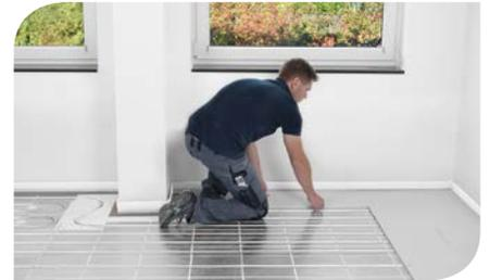
Mit Reststück ( $\geq 20$  cm) im schleppenden Verband beginnen (Fugenversatz  $\geq 20$  cm).
