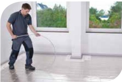
Systemrohr in einem großen Bogen von oben spannungsfrei in die Rillen drücken.
