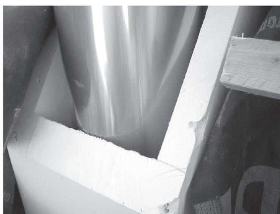
**7** Der F90-Schacht endet bündig unter der nicht-brennbaren Dachhaut.
