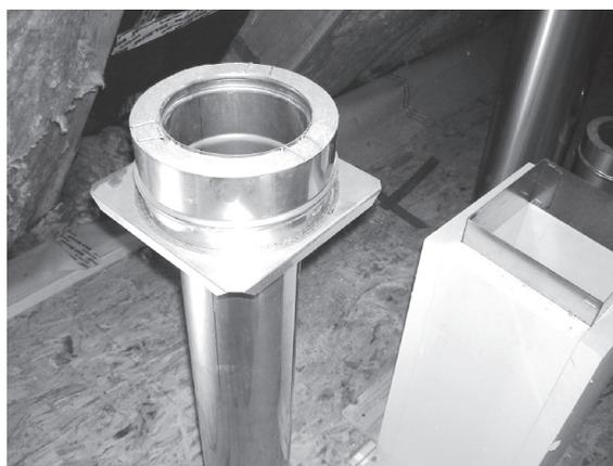
**5** Schnelle und einfache Montage Dank umfangreichem Bauteilsortiment. Das UNITEC/ UNITHERM Übergangselement stellt den Übergang zur Mündung her.
