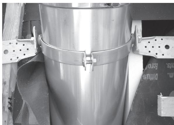
**9** Um Scher- oder Zugkräfte zu vermeiden, ist die Mündung mit der Halteschelle dauerhaft auf der Sparrenkonstruktion zu befestigen.
