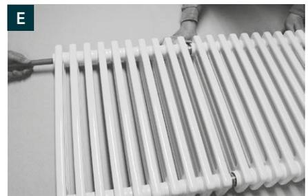
Drehen Sie mit der Nippelstange abwechselnd beide Nippel fest. Das Drehmoment sollte bei  $90 \pm 10$  Nm liegen. Unsymmetrisch angezogene Nippel verursachen Leckagen!
