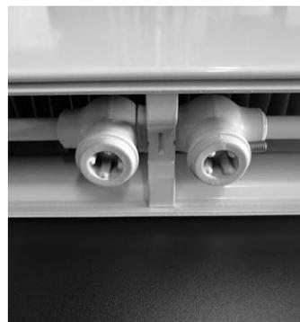
Beispiel Vertikalheizkörper Mittenanschlussheizkörper Plan
