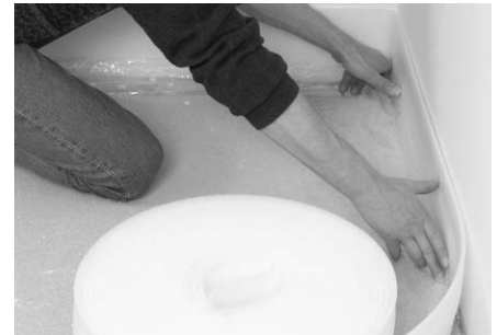
Abb. 1: Randdämmstreifen mit Folienstreifen
