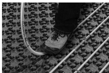
Schnelle und saubere Verlegung durch Überlappungstechnik.
