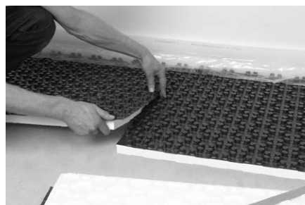
Schnelle und saubere Verlegung durch Überlappungstechnik.
