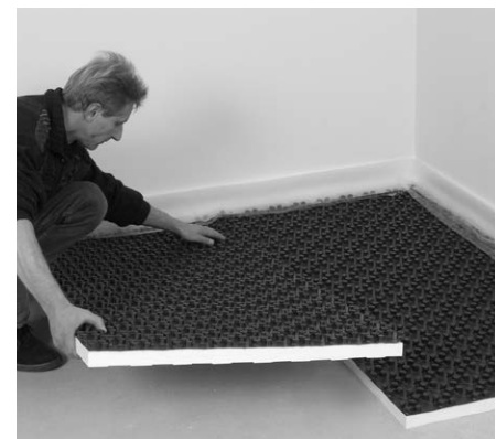
Abb. 1: Verlegung von Systemelementen
