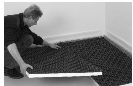
FLOORTEC System-Noppenplatten auslegen.
