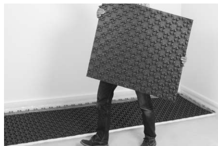
Verlegung von links nach rechts.
