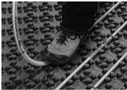
Abb. 1: Pe-Xcellent 5 Fußbodenheizungsrohr Verlegung
