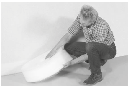
Randdämmstreifen mit seitlicher Folienschürze auslegen,
