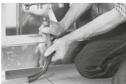
Heizrohr am Verteiler anbringen, fertig!
