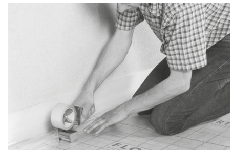
Randdämmstreifen (beim Einsatz von Fließestrich) abkleben.
