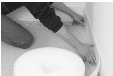
Randdämmstreifen mit seitlicher Folienschürze auslegen.
