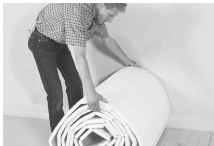
Tackersystemelemente auslegen und ausrollen.
