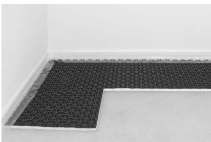
Mit dem abgeschnittenen Elementteil nächste Verlegereihe beginnen.
