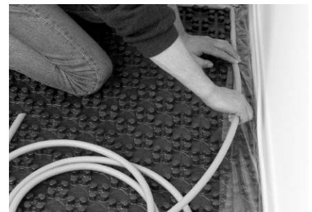
Abb. 2: Fixierung des Folienstreifens
