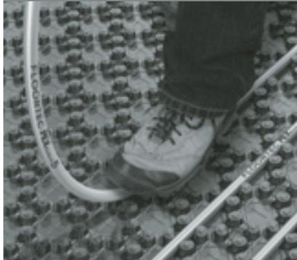
Abb. 1: Pe-Xcellent 5 Fußbodenheizungsrohr Verlegung
