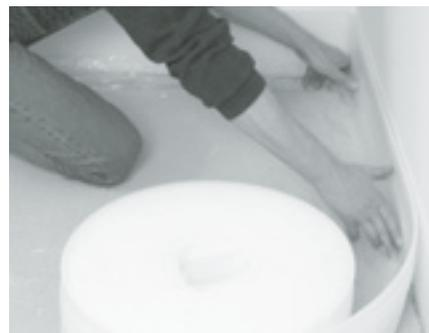
Abb. 1: Randdämmstreifen mit Foliestreifen
