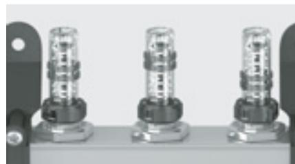
Abb. 1: Vorlauf - eingebaute Abgleichoberteile
