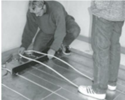
Danach erfolgt das Eindrücken der Rohre in die Rillen mit einer Hartholzplatte (3 cm dick/60–80 cm lang) durch einen leichten Schlag mit dem Hammer.
