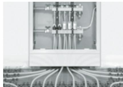
Abb. 4: Heizrohr am Verteiler anbringen, fertig!
