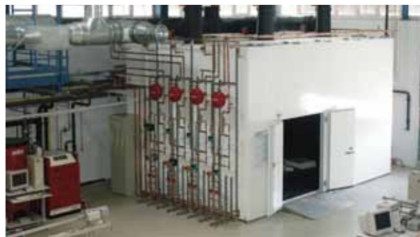
Zastosowana kabina klimatyczna (pomieszczenie porównawcze)
