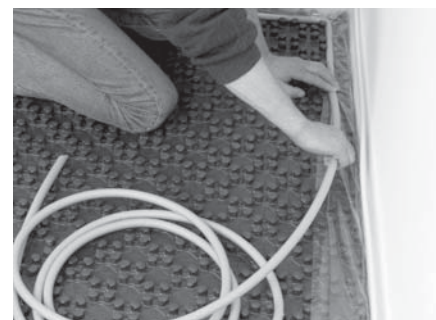
Applicare il nastro di isolamento perimetrale...
