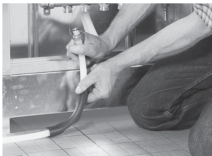
Collegare il tubo al collettore e il sistema è completo!
