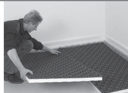
Fissare i pannelli del sistema Noppen FLOORTEC
