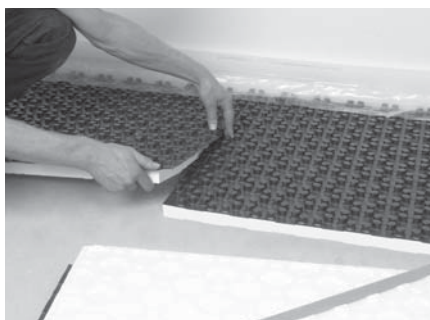
Posa rapida e precisa grazie alla tecnica di sovrapposizione
