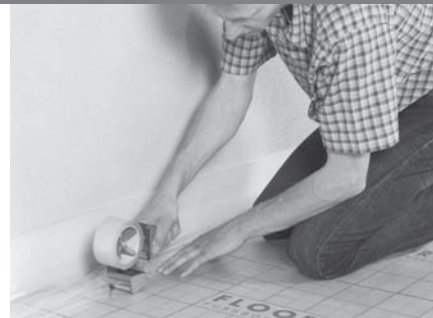
Nastro di isolamento perimetrale (se utilizzato massetto autolivellante)
