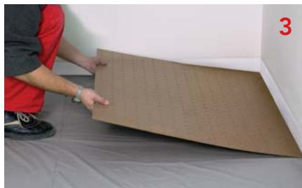
Die Lochfaserplatte wird auf die verlegte Isolierung und Feuchtigkeitssperffolie gelegt. Falls Anpassungen der Lochfaserplatte notwendig werden, können diese mit Kreissäge, Stichsäge oder Teppichmesser vorgenommen werden.
