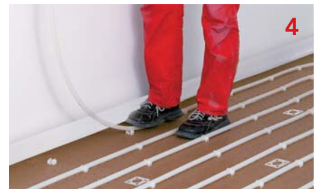
Fixieren der Lochfaserplatte mit Plattenverbindern. Befestigen der Heizrohre durch die in variablen Abständen eingesteckten Rohr-clips.
