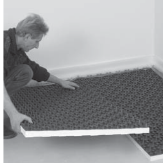
FLOORTEC System-Noppenplatten auslegen.
