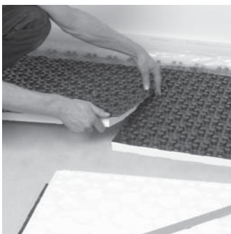
Schnelle und saubere Verlegung durch Überlappungstechnik.
