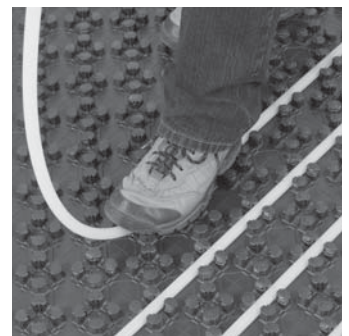
Das flexible und leicht zu verlegende PE-Xa Systemrohr (14 x 2 mm, 17 x 2 mm) oder Aluverbundrohr (16x2) einfach mit dem Fuß in die trittfest ausgeschäumten Rohthaltenoppen eindrücken.
