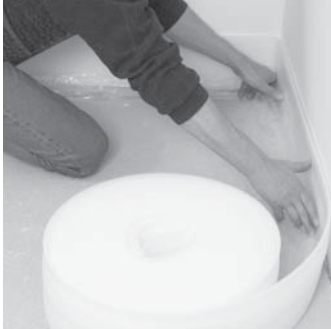
Randdämmstreifen mit seitlicher Folienschürze auslegen.
