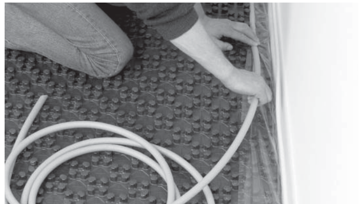
Abb. 2: Fixierung des Foliestreifens
