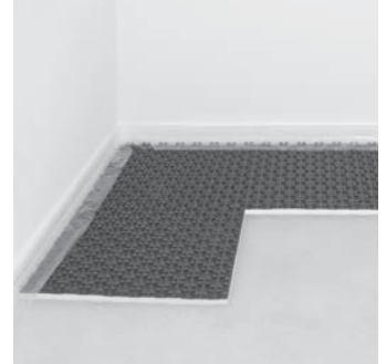
Mit dem abgeschnittenen Elementteil nächste Verlegereihe beginnen.
