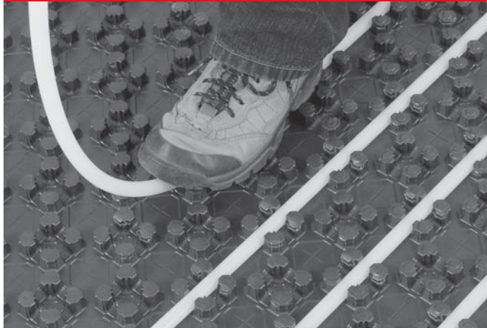
Abb. 1: PE-Xa Systemrohrverlegung
