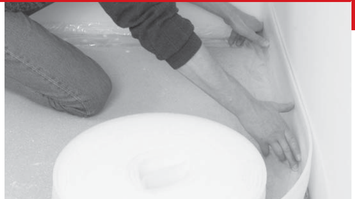
Abb. 1: Randdämmstreifen mit Foliestreifen
