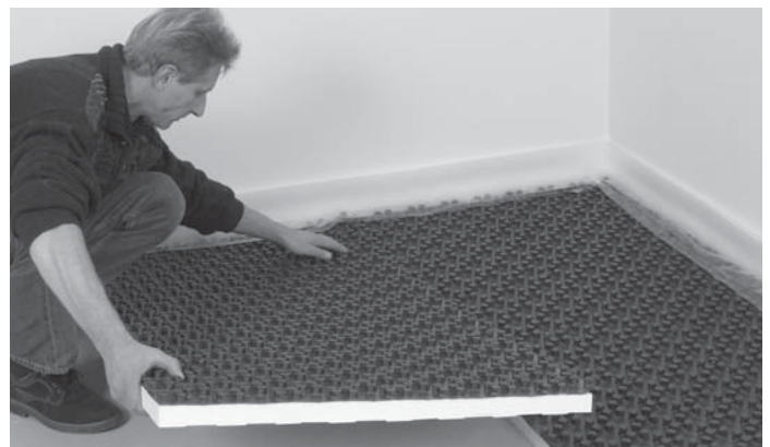
Abb. 1: Verlegung von Systemelementen
