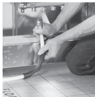
Heizrohr am Verteiler anbringen, fertig!
