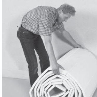
Tackersystemelemente auslegen und ausrollen.
