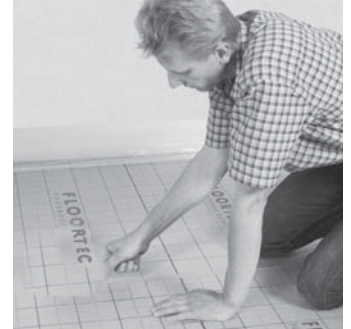
Dämmrollen sind mit einem 3 cm Selbstklebestreifen versehen und überlappen am Stoß.
