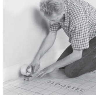
Randdämmstreifen (beim Einsatz von Fließestrich) abkleben.
