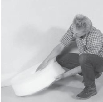
Randdämmstreifen mit seitlicher Folienschürze auslegen,
