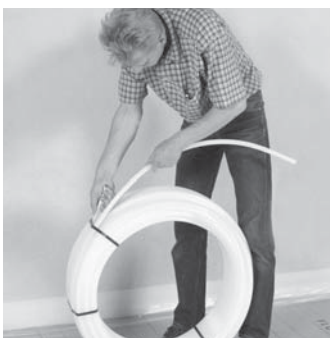
Tackersystem-Heizrohr mit Hilfe des ...
