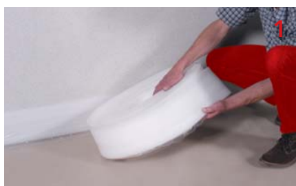
Randdämmstreifen mit seitlicher Folienschürze auslegen. Die Art und Beschaffenheit des Dämmstreifens ist frei wählbar.
