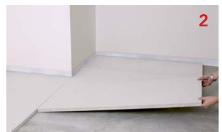
Die Verlegung der Wärme-/Trittschalldämmung erfolgt auf besenreinem Untergrund. Zur Auswahl stehen verschiedene Materialien, z. B. Hanf oder Holzfaser, Mineralfaser (Stein-/Glaswolle) oder Polystyrol.
