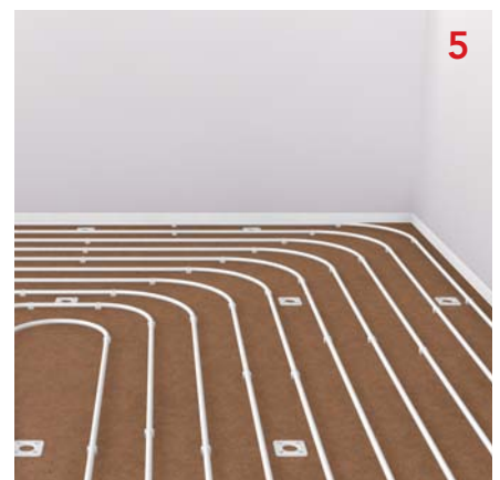
Nach Verlegung der Fußbodenheizungsrohre kann sofort mit den Estricharbeiten begonnen werden.
