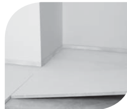
2. Die Verlegung der Wärme-/Trittschalldämmung erfolgt auf besenreinem Untergrund. Zur Auswahl stehen verschiedene Materialien, z. B. Hanf oder Holzfaser, Mineralfaser (Stein-/Glaswolle) oder Polystyrol.
