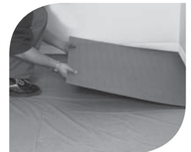
3. Die Lochfaserplatte wird auf die verlegte Isolierung und Feuchtigkeitssperffolie gelegt. Falls Anpassungen der Lochfaserplatte notwendig werden, können diese mit Kreissäge, Stichsäge oder Teppichmesser vorgenommen werden.
