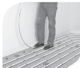
4. Fixieren der Lochfaserplatte mit Plattenverbinder. Befestigen der Heizrohre durch die in variablen Abständen eingesteckten Rohrclips.
