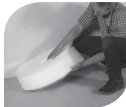
1. Randdämmstreifen mit seitlicher Folienschürze auslegen. Die Art und Beschaffenheit des Dämmstreifens ist frei wählbar.
