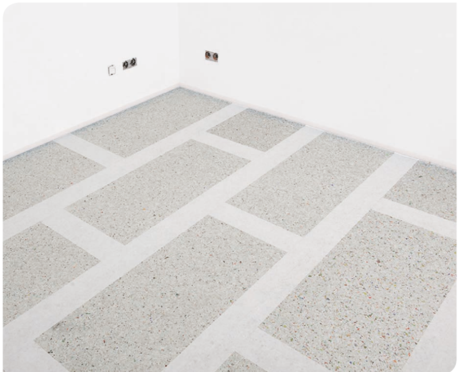
Abb 9: Die fertige Fläche vor Verschmutzung schützen, Laufwege ausreichend, z.B. mit Dämmplatten, abdecken.
