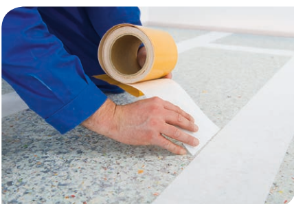
Abb 18 Im Falle eines Fliesenbelags Stoßstellen und Kopfstöße mit Fugenkleband abkleben
