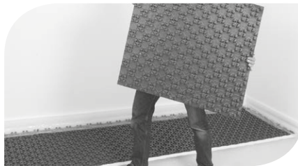
Verlegung von links nach rechts.
