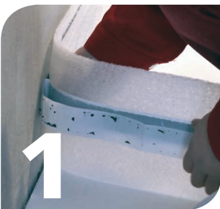
1 VERLEGUNG DES RANDDÄMMSTREIFENS
