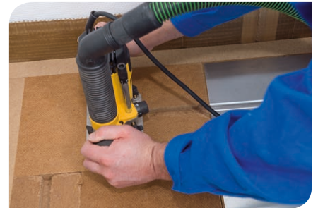
Abb 6: Mit einer Oberfräse individuelle Rohrführungen in großen Bögen ausschneiden
