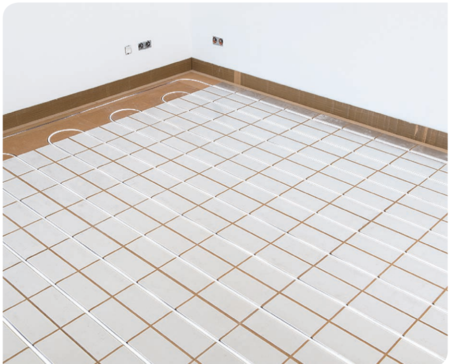
Abb 9: Fertig verlegte Fläche System ÖKO – Bis zur Verlegung der Lastverteilschicht oder des Oberbodens Laufwege, z.B. mit Dämmplatten, vor Stauchung schützen
