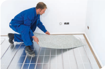
Abb 1: Die Verlegung auf den angeklebten Heizelementen in einer Ecke beginnen
