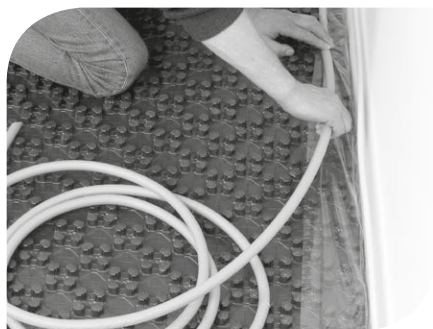
Abb. 2: Fixierung des Folienstreifens
