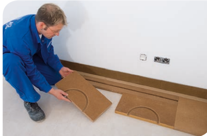
Abb 2: Mit den Kopfelementen die Verlegung in einer Ecke beginnen
