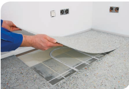
Abb 7: Die Fixierung ablüften und die Elemente wieder auflegen
