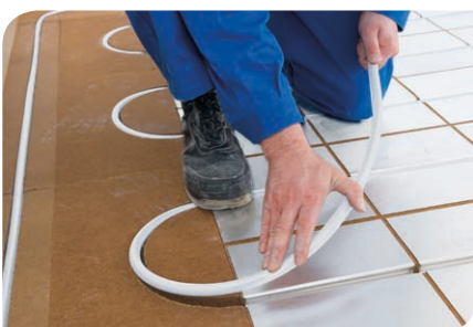
Abb 8: Direkt nach den Kopfelementen das Systemrohr nicht hochziehen
