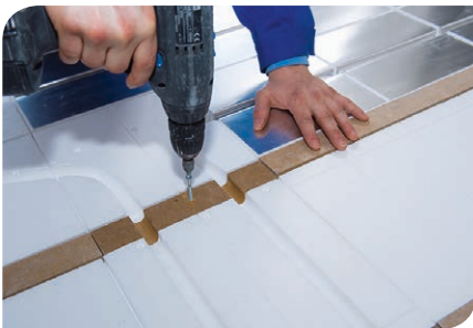
Abb 7: Im Türdurchgang das Rahmenholz, wenn möglich im Untergrund verschrauben
