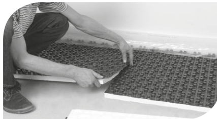
Schnelle und saubere Verlegung durch Überlappungstechnik.
