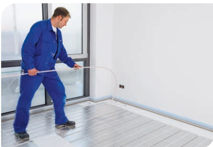
Abb 8: Systemrohr in einem großen Bogen von oben spannungsfrei in die Rillen drücken
