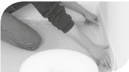
Randdämmstreifen mit seitlicher Folienschürze auslegen.
