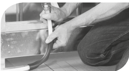
Abb. 7: Heizrohr am Verteiler anbringen, fertig!
