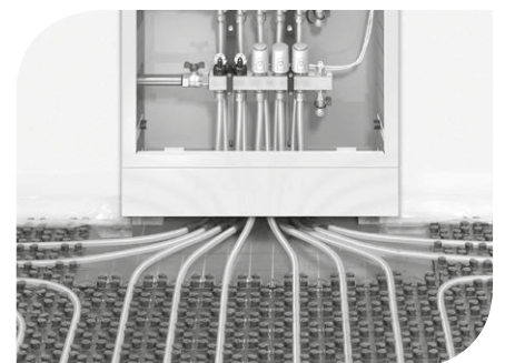
Abb. 4: Heizrohr am Verteiler anbringen, fertig!
