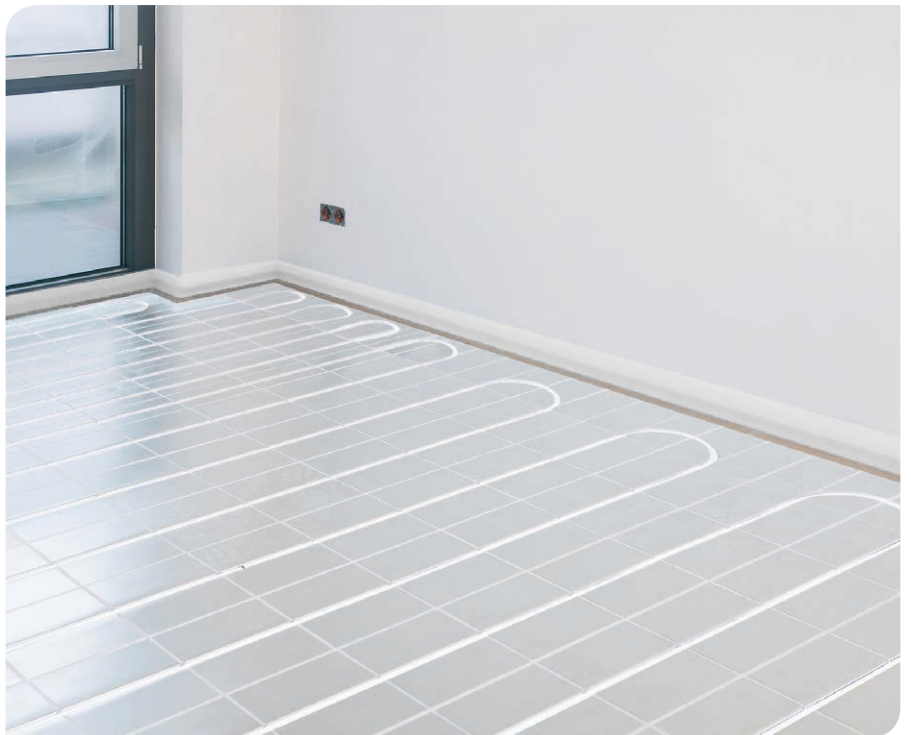
Abb 9: Fertig verlegte Fläche System EPS – Bis zur Verlegung der Lastverteilschicht oder des Oberbodens Laufwege, z.B. mit Dämmplatten, vor Stauchung schützen
