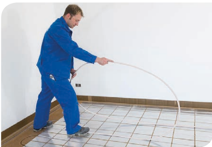
Abb 7: Systemrohr in einem großen Bogen von oben spannungsfrei in die Rillen drücken
