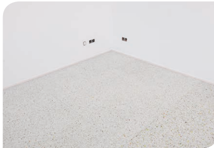
Abb 5: Bei der Gesamtfläche ist auf eine spannungsfreie Verlegung zu achten
