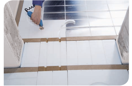
Abb 6: Mit dem Heißschneider individuelle Rohrführungen in großen Bögen ausschneiden
