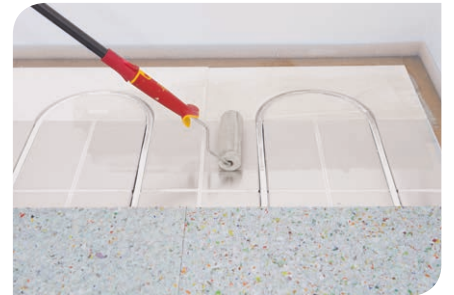
Abb 6: STRONGBOARD FL bei Fliesenbelag vollflächig auf den Heizelementen fixieren
