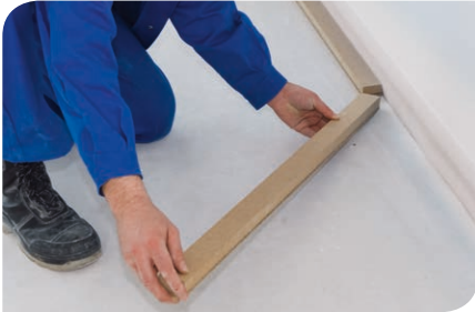
Abb 1: Randdämmstreifen und Rahmenholz auf tragfähigem, ebenen Untergrund verlegen
