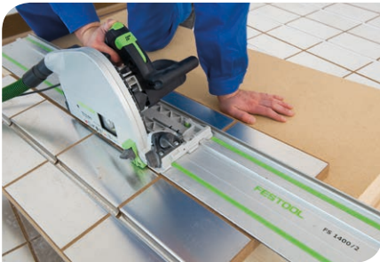
Abb 4: Nach Bedarf die Heizelemente zwischen den Wärmeleitblechen zuschneiden
