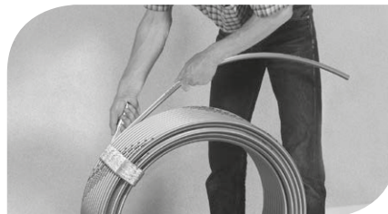
Abb. 5: Tackersystem-Heizrohr mit Hilfe des ...
