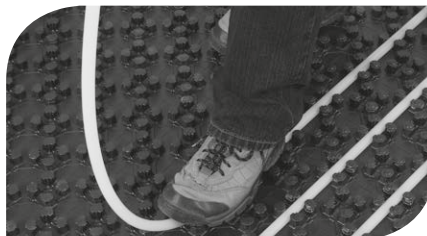
Schnelle und saubere Verlegung durch Überlappungstechnik.
