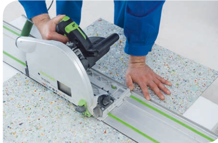
Abb 2: Notwendige Zuschnitte können mit einer Kreissäge erfolgen
