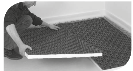
COSMO System-Noppenplatten auslegen.
