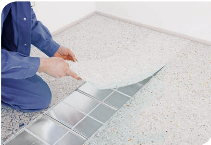
Abb 4: Kleinere Stücke in der vorletzten Reihe verlegen und den Verband beibehalten
