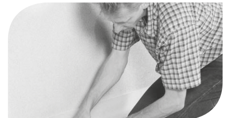
Abb. 3: Randdämmstreifen (beim Einsatz von Fließestrich) abkleben.
