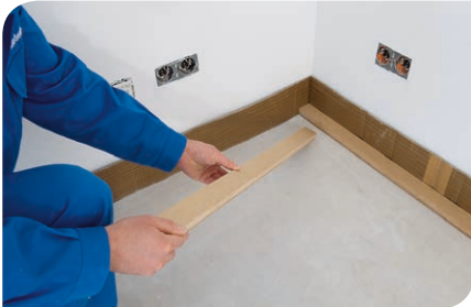
Abb 1: Randdämmstreifen und Rahmenholz auf tragfähigem, ebenen Untergrund verlegen
