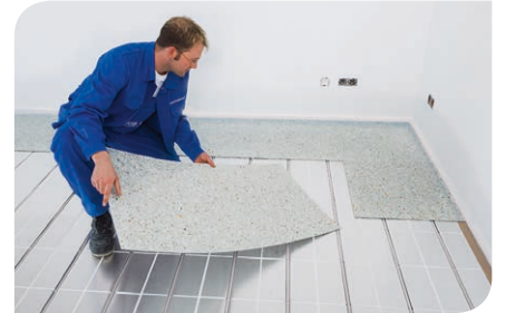
Abb 3: Die Verlegung erfolgt im Verband – Der Überstand sollte > 20 cm sein
