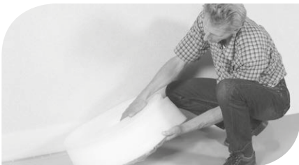
Abb. 1: Randdämmstreifen mit seitlicher Folienschürze auslegen,
