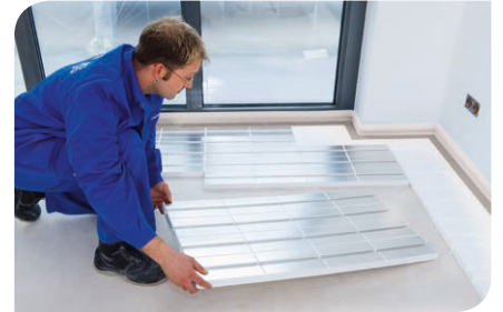
Abb 3: Die werksseitig mit Aluminiumblech kaschierten Heizelemente vollflächig auslegen
