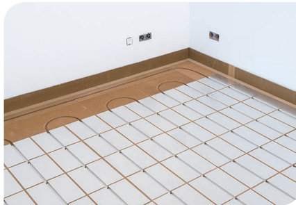
Abb 5: Randflächen und Ecken mit Randelementen auffüllen
