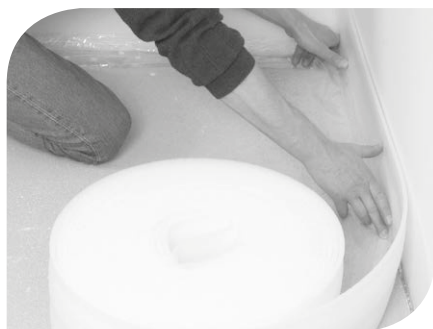
Abb. 1: Randdämmstreifen mit Folienstreifen
