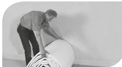
Abb. 2: Tackersystemelemente auslegen und ausrollen.
