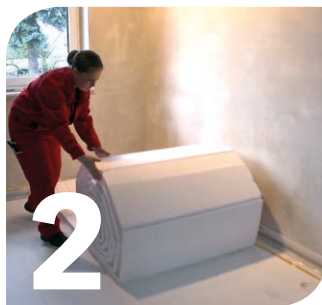
2 DÄMMPLATTEN AUSROLLEN
