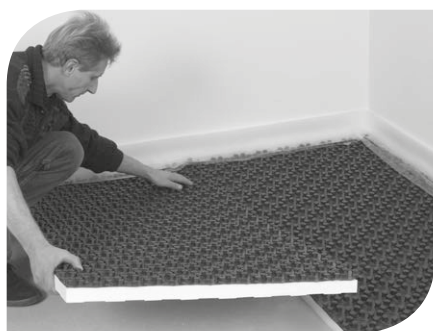
Abb. 1: Verlegung von Systemelementen
