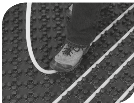
Abb. 1: Pexcellent Fußbodenheizungsrohr Verlegung
