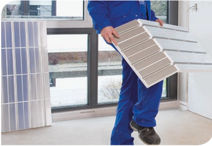
E Abb 4: Elemente mittels Sollbruchstellen anpassen und Ecken mit Randelementen auffüllen
