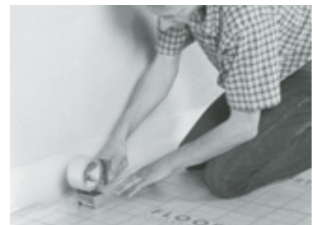
Randdämmstreifen (beim Einsatz von Fließestrich) abkleben.
