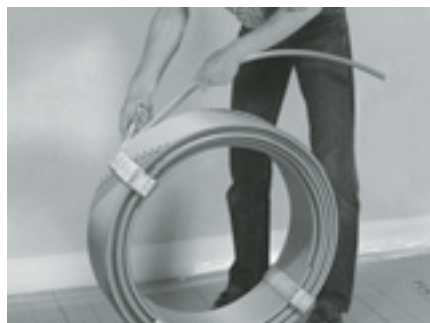
Tackersystem-Heizrohr mit Hilfe des ...
