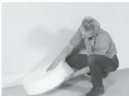
Randdämmstreifen mit seitlicher Folienschürze auslegen,
