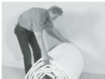
Tackersystemelemente auslegen und ausrollen.
