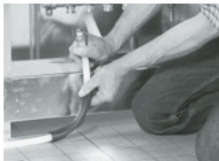
Heizrohr am Verteiler anbringen, fertig!
