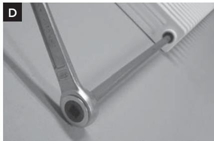
Führen Sie die Nippelstange durch einen Anschluss- vom zuletzt angesetzten Block- bis in den Nippel. Der Vierkant an der Nippelstange ist für die Windenknarre vorgesehen.
